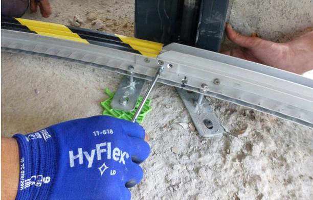
Puis fixé sur la maçonnerie à l'aide d'équerres et d'écrous sertis. Les 2 dormants doivent être rigoureusement verticaux.
