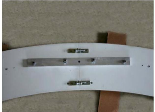
Le rail extérieur est accroché dans l'emplacement prévu dans le haut du dormant puis il est pivoté.
