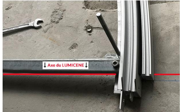
L'utilisation d'un laser et d'une mire permet de régler la hauteur du rail sur chaque point de fixation de façon millimétrique. Le haut du rail est aligné sur le niveau du sol fini.
