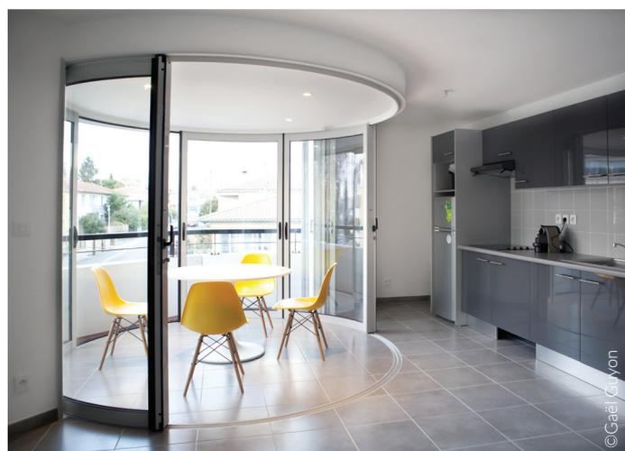
*Les 180° de parois en verre courbe de LUMICENE® coulissent sur 2 rails - haut et bas - et permettent ainsi de transformer ponctuellement la salle à manger de l'appartement en balcon.*
